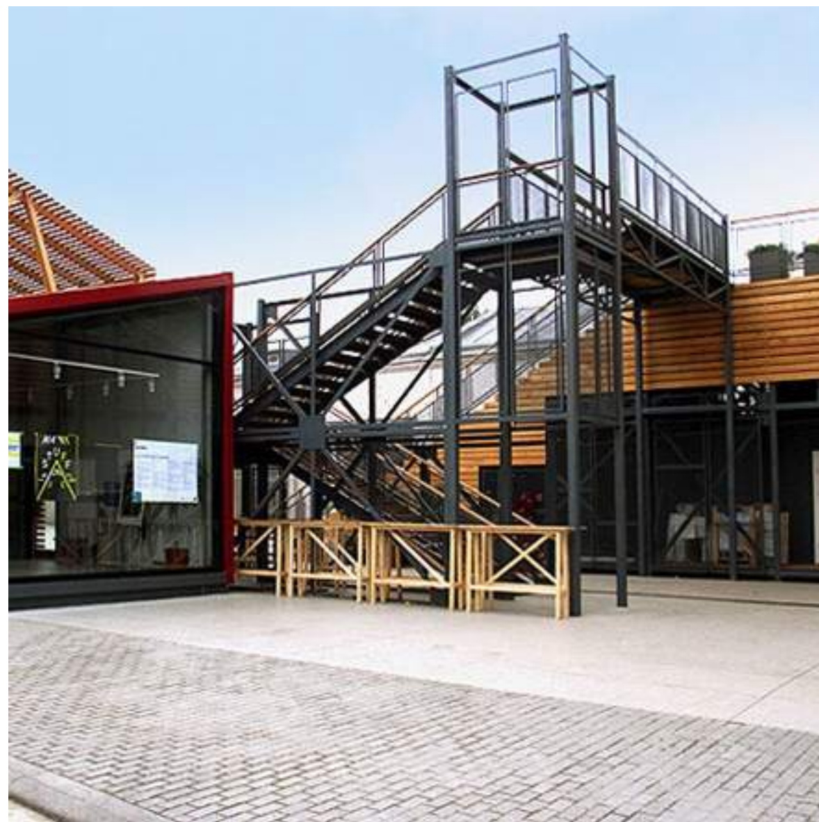
Здание Института и бара Стрелка
