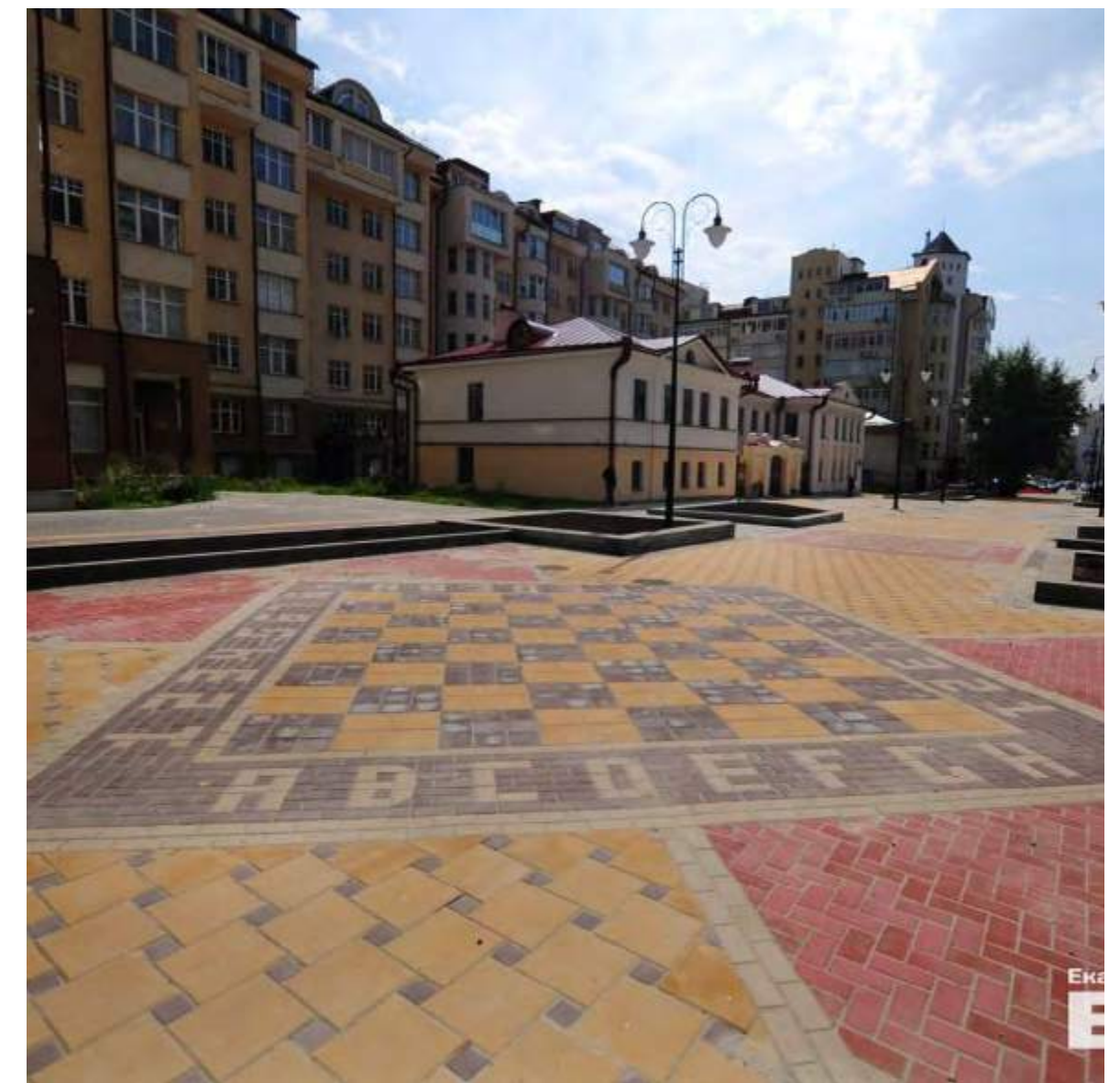
Реконструкция Красноармейской улицы на участке от ул. Карла Маркса до ул. Энгельса Проектные и строительные работы - «Атомстройкомплекс» Екатеринбург, Россия 2015
