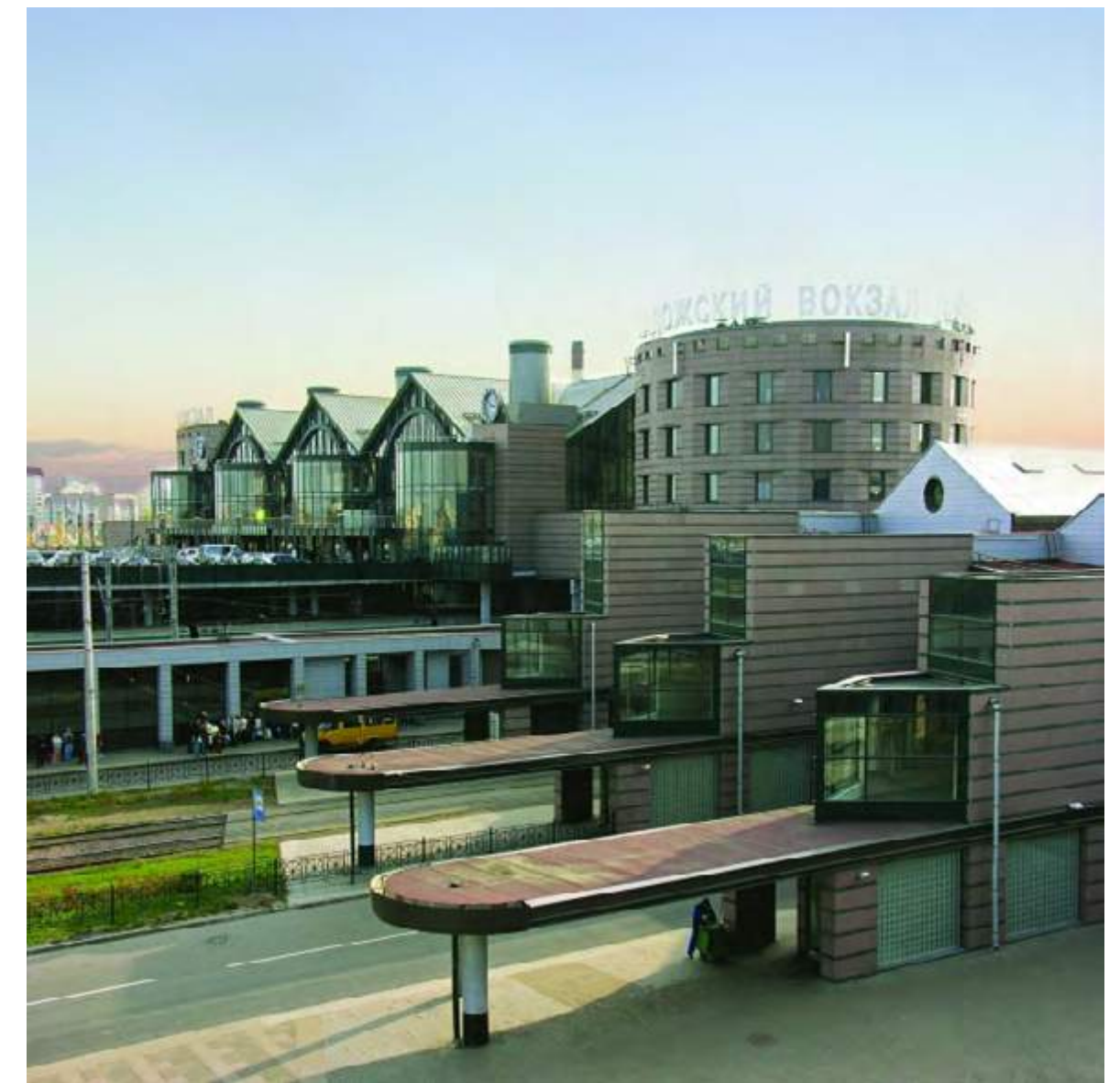
Вокзальный комплекс Ладожский, Санкт-Петербург Студия 44 Санкт-Петербург, Россия 2001 – 2002 / 2001 – 2003
